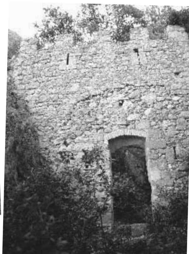
A la foto de l'esquerra: les escales tallades a la roca són perfectament visibles. A la de la dreta: detall de la façana de ponent.
